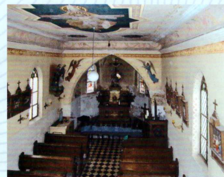
Schon bald könnte ein neuer Kapellenverein in Gemeinschaftsarbeit die Taucherkapelle in Blechhammer sanieren.
