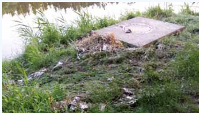
Die Verlegung des Kanals ist Bürgermeister Hoffmann zu teuer. Ein Antrag der Bürgerliste könnte Abhilfe schaffen.
